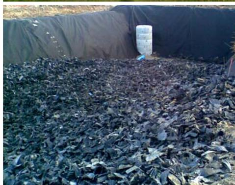
Bassin d'infiltration enterré avec des broyats de pneus
